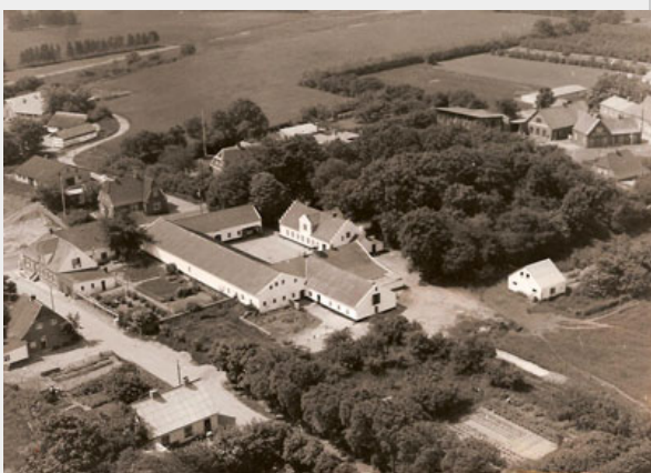
Luftfoto af Lindegaard set fra nordøst omkring 1950. Den lille hvide bygning til højre er resten af den omtalte nye svinestald til 350.000 kr. Fortsættelsen af den lå i buskadset mod højre, men var allerede brækket ned på dette tidspunkt. Billedet er stillet til rådighed af Inger Schnedler, Vandel.
