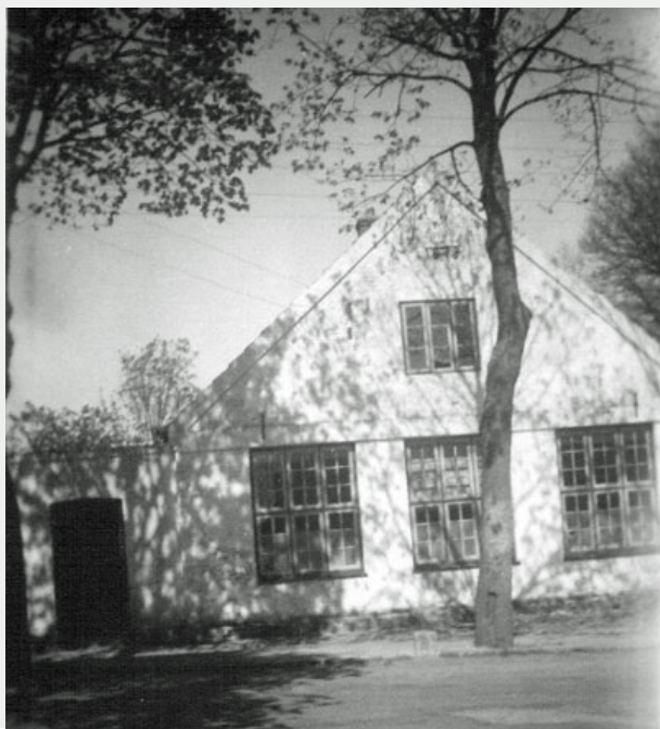
Vandel "store" skole omkring 1948.
