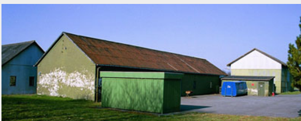
Karlsmindegaarden set fra nordøst. I midten laden og til højre den af Karl Kaspersen opførte staklade til højre.
