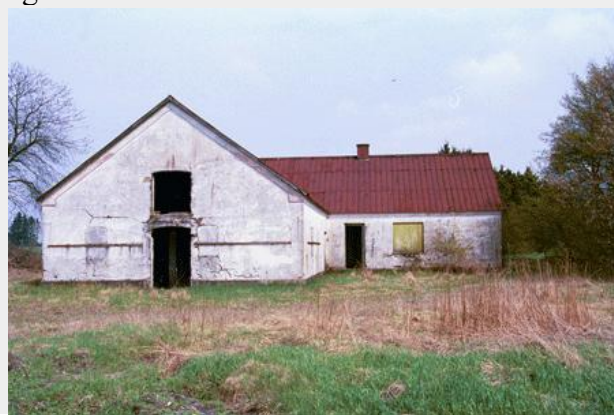
Ejendommens bygninger står endnu på stedet. Foto fra 2003. Fotograf N.M. Schaiffel Nielsen.
