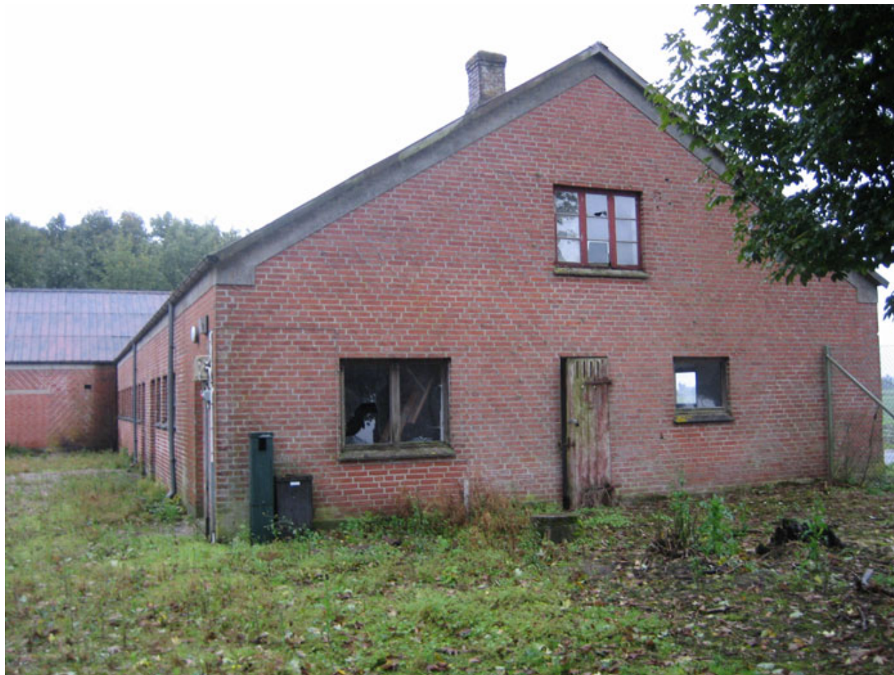
Kostaldens østre gavlparti. Det venstre hjørne lå tæt på stuehuset. De nederste vinduer er i modsætning til det øverste og døren foruden ikke de oprindelige. Bag vinduet til venstre var der vaskerum med indmuret gruekedel. Skorsten dertil ses på taget. Til skorstenen var også tilsluttet en kakkelovn, som stod i karlekammeret bag vinduet foroven. Døren i midten er ind til toilettet, ganske vist af brædder med spand, men dog anbragt i bygningen og ikke som ofte i et lille skur i skovkanten bagved. Der var ikke indlagt vand på gården. Vand til vask og husholdning kom fra en brønd med håndpumpe på gårdspladsen. Bag vinduet til højre, eller et tilstødende rum bag dette, var der malkerum.
