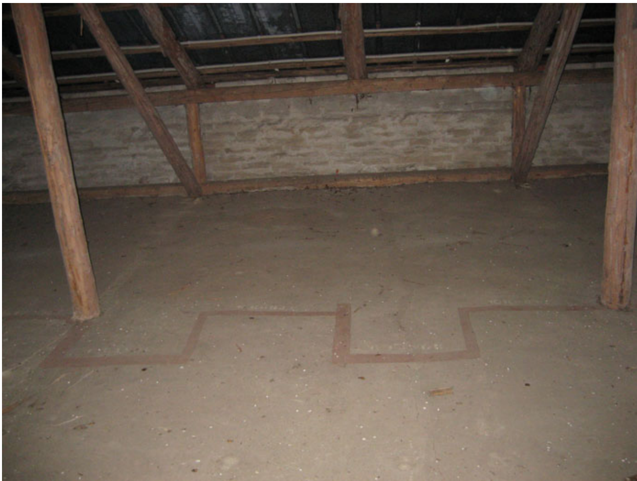
Markeringer til anbringelse af andet materiel fra Artilleriflyverbatteri Vandel's tid.
