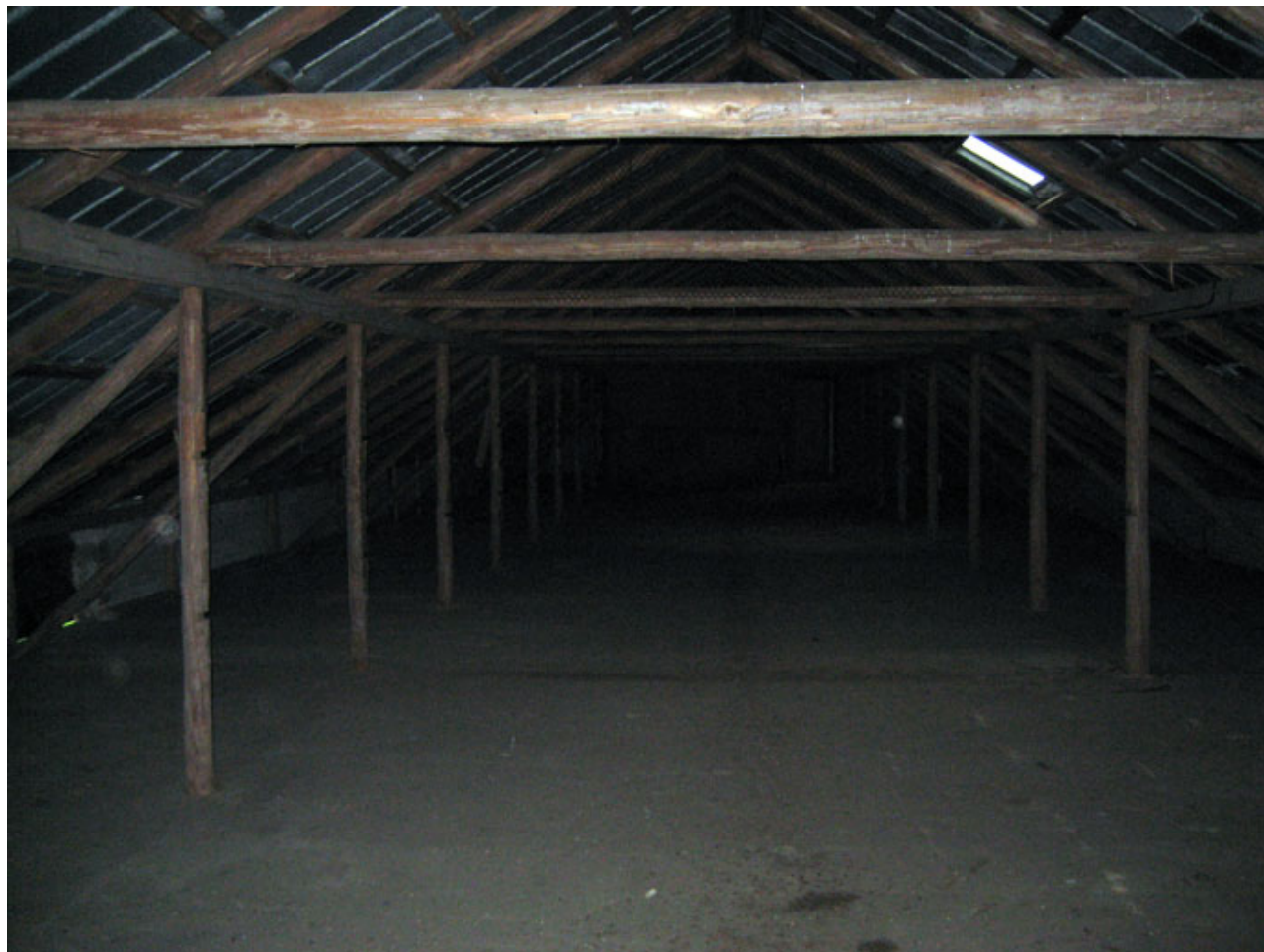
Høloftet over kostalden. Bemærk den ca. 1 meter høje trempel, som giver god højde i loftsrummet.
