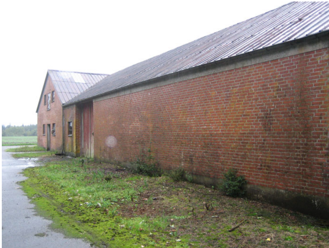
Ladebygningens vestre side. Også her ses murens krydsforbandt i sildebensmønster. Bygningerne bærer det oprindelige bliktag fra 1930'erne.
