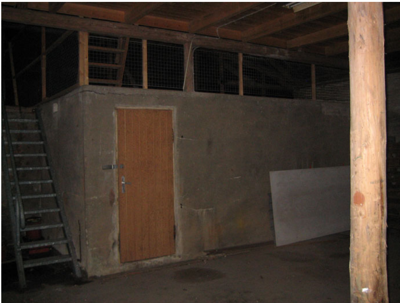
Vandbeholderen i enden af laden. Døren er kommet til siden ligesom nettet foroven. Foroven blev halmen fra tærskværkets halmpresser skubbet op ad en slidske til hø- og halmloftet. Trappen fører op på høloftet over stalden og var oprindeligt af træ.
