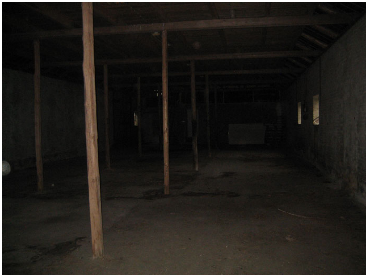
Laderummet indvendigt. "Kraft"- elinstallationerne til højre for tærskelværk og kværn.
