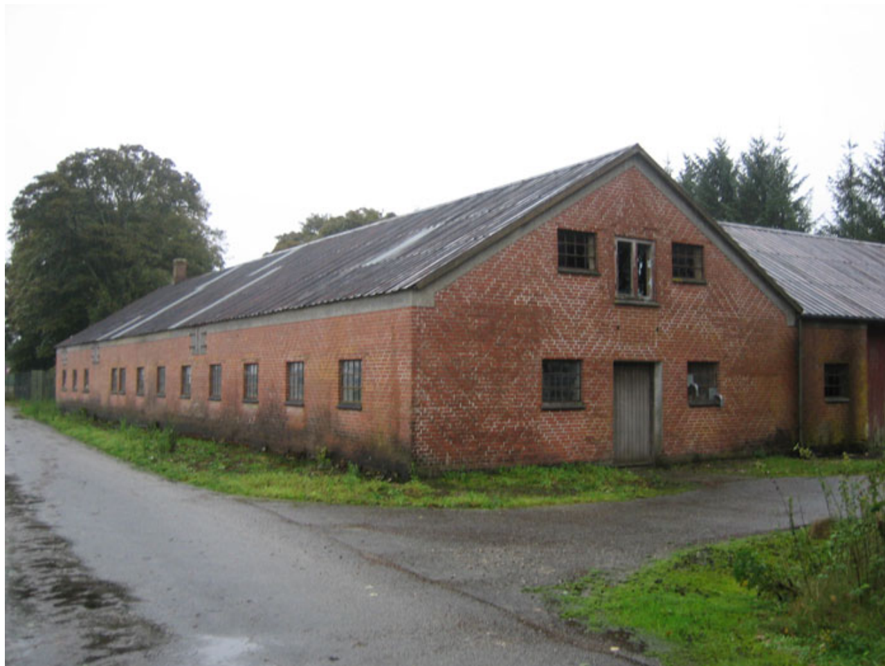
Kostalden set fra vest. Her har køerne gået ind og ud. Bemærk loftslemmene i tremplen og den tilmurede lem i gavlen, hvor hø og halm kunne forkes ind.
