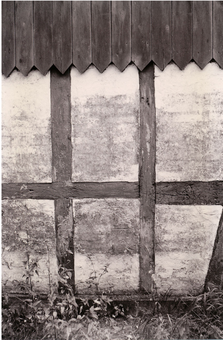
Udsnit af ladens bindingsværk og trempe.
