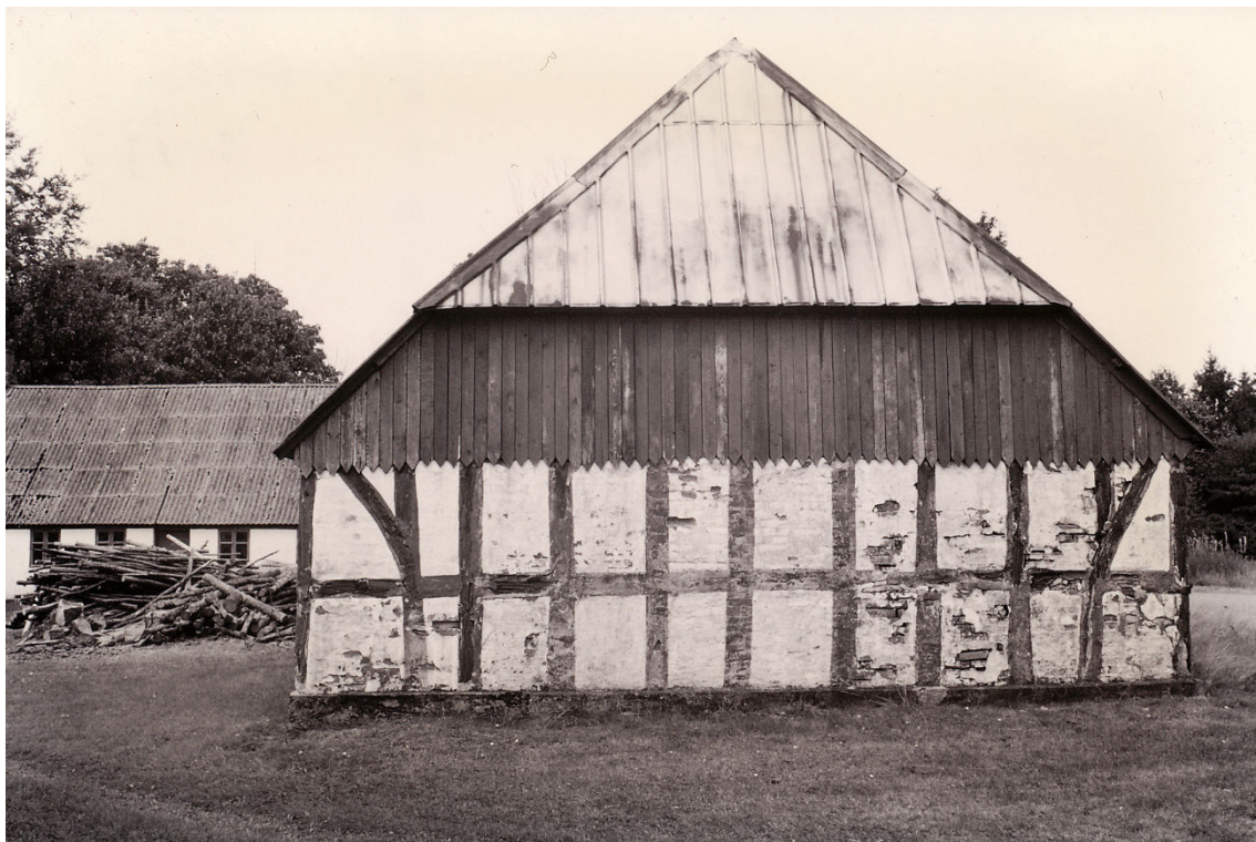
Ladens sydgavl med det karakteristiske bindingsværk, trempel og valmet bliktag. Huset har før båret strå- eller lyngtag.
