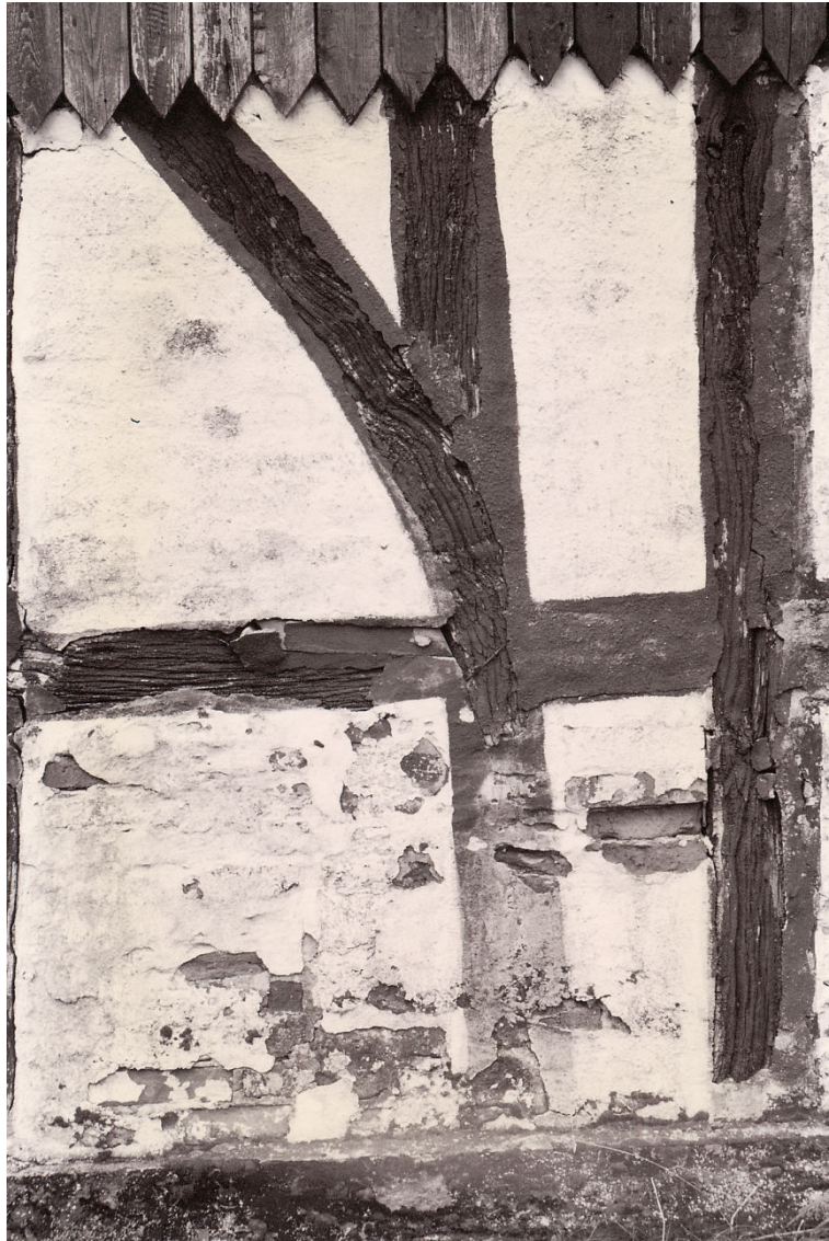
Ladens bindingsværk med hjørnestøtte og trempe
