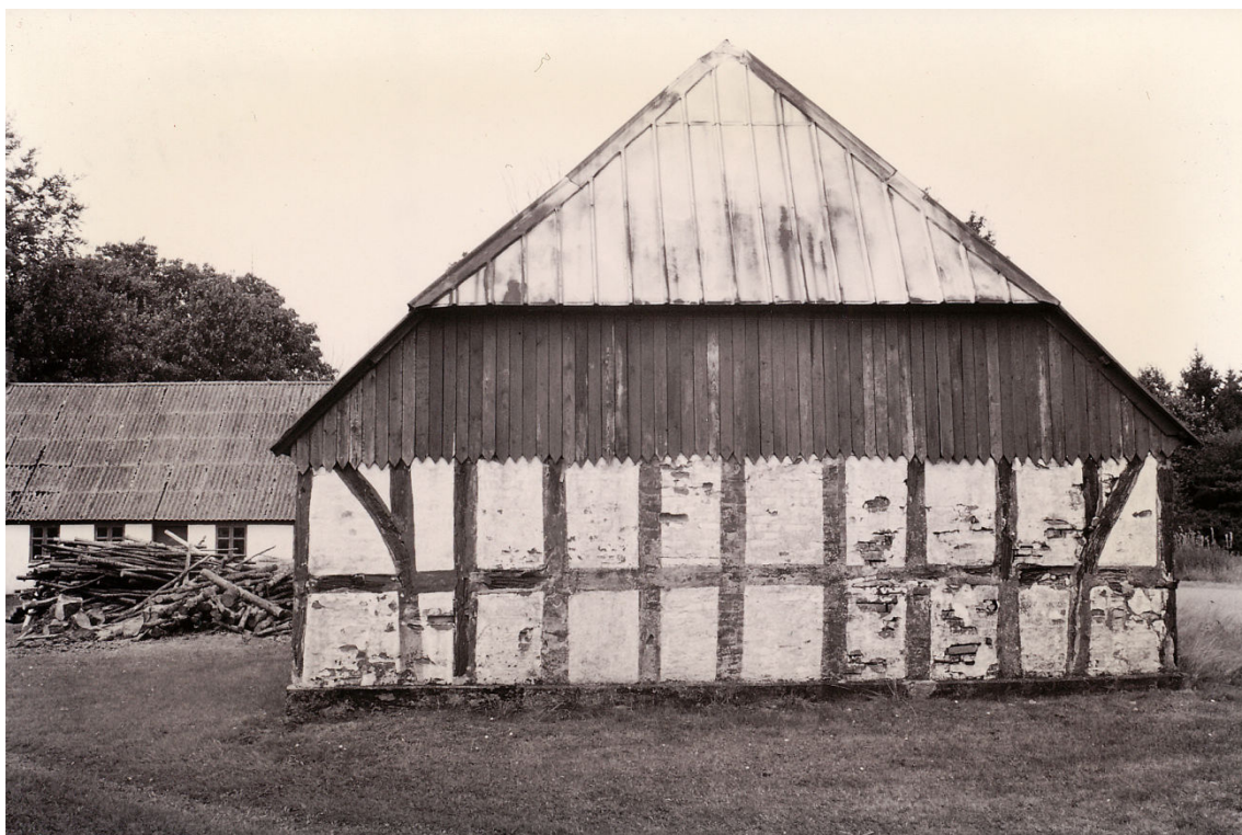
Ladens sydgavl med det karakteristiske bindingsværk, trempel og valmet bliktag. Huset har før båret strå- eller lyngtag.
