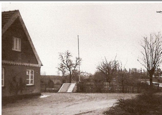
Nedgangen til kælderen i haven som Kristian Iversen nævner i sin fortælling.
