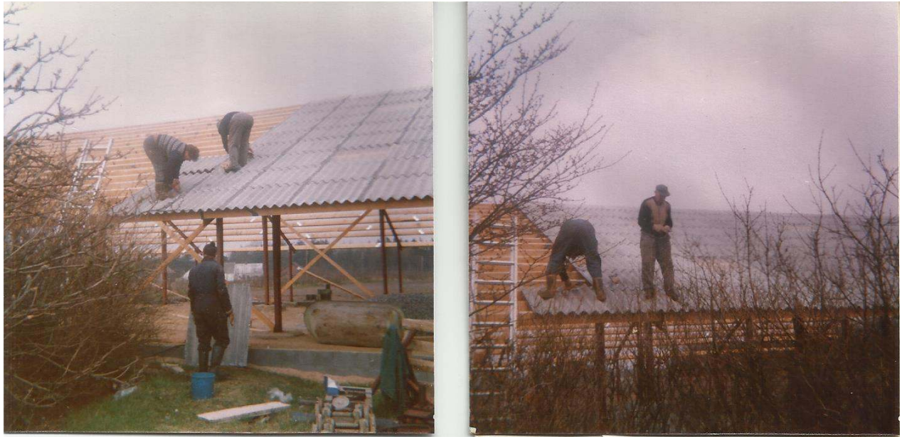
Mads Kaspersen var meget hjælpsom over andre. Her står han på taget og hjælper med at lægge tagplader på Villy Villadsens nye maskinhus i Fitting. Foto udlånt af Villy Villadsen.
