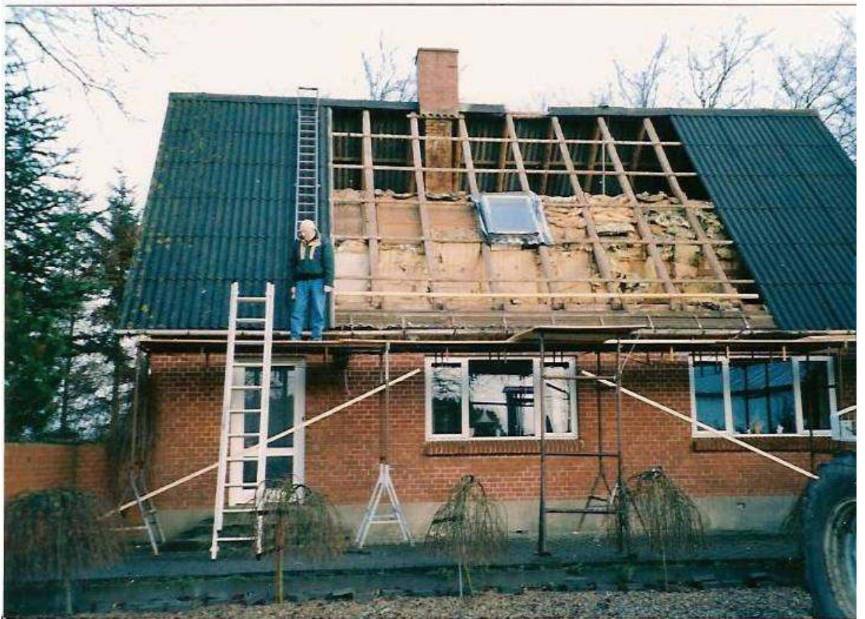
Tirsdag den 26. januar 1999 påbegyndtes udskiftning af det gamle tag på stuehuset. Sv. Aage Jensen er gået til vejrs for inspektion.
