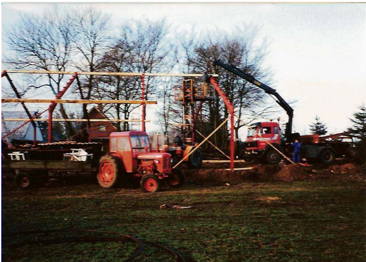
Spærene rejses til det nye maskinhus i januar 1995. Bemærk Bukh-traktoren i forgrunden; den ene af de to som "gemte sig omme bagved".
