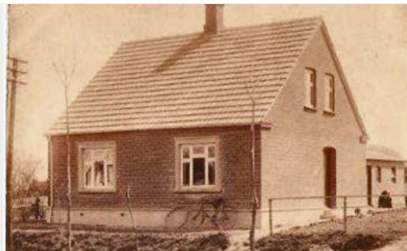
Huset Gl. Stationsvej 3 i Vandel. Foto udlånt af Eli Jensen, Vejle.
