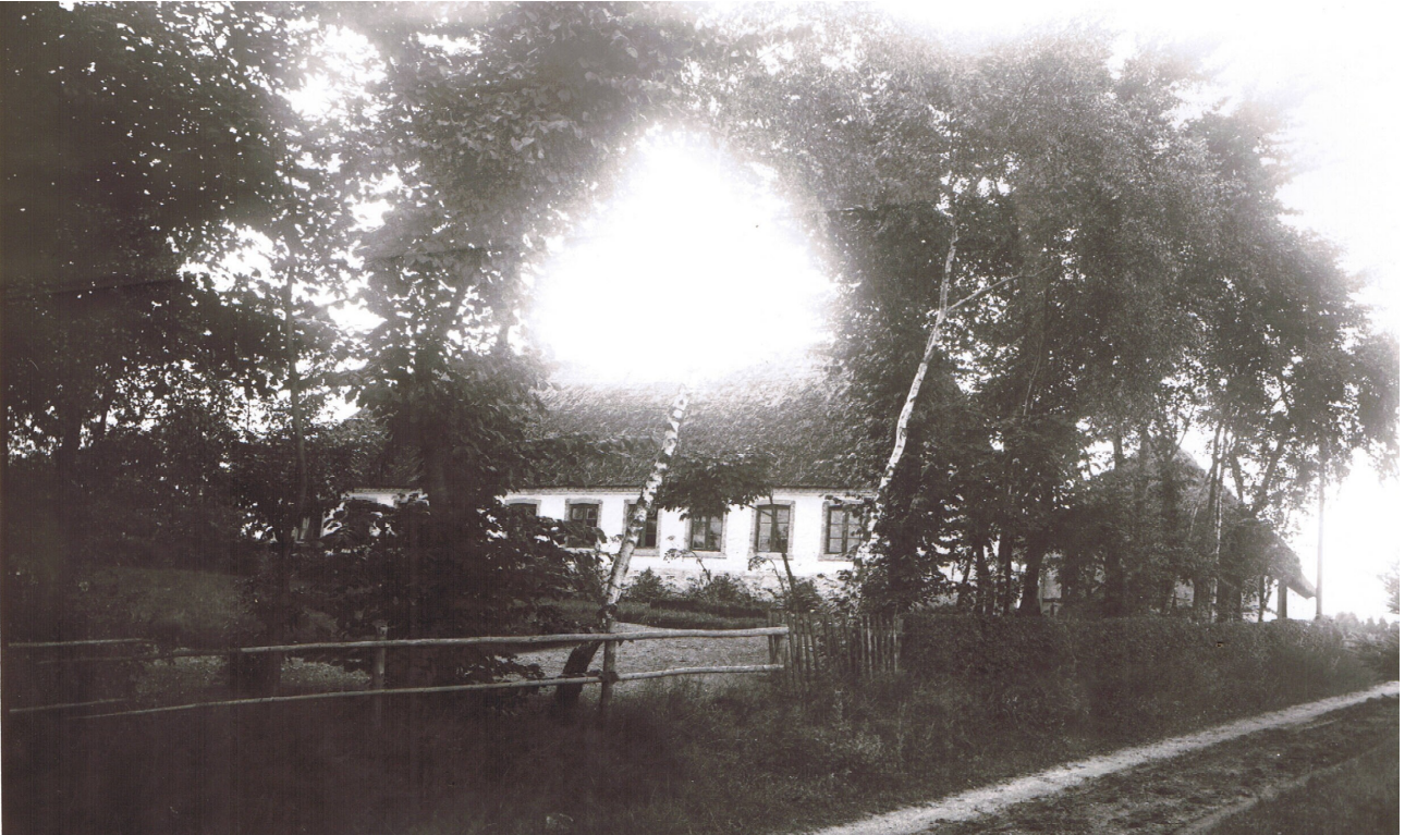
Adressen er Hævejen 35. Gården hed tidligere Kårehøjgård med skiftede navn til Højlundgård. Billedet dårligt, men det bedste der kunne findes. Hævejen ses tydeligt i billedets forgrund. (Billede fra Randbøl Sogns Lokalarkiv).
