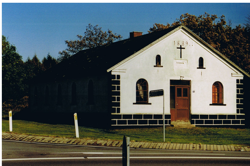
Sognets ældste missionshus, Bethesda, i Frederikshåb står og forfalder. Efter dette billede er taget er der sat en ny dør i. Til gengæld er pudset på soklen begyndt at falde af.
