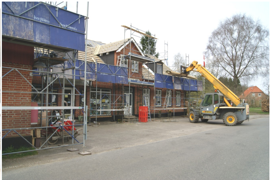
Bindeballe købmandsgård pakket ind i stillads fra firmaet Helge Frandsen A/S.
