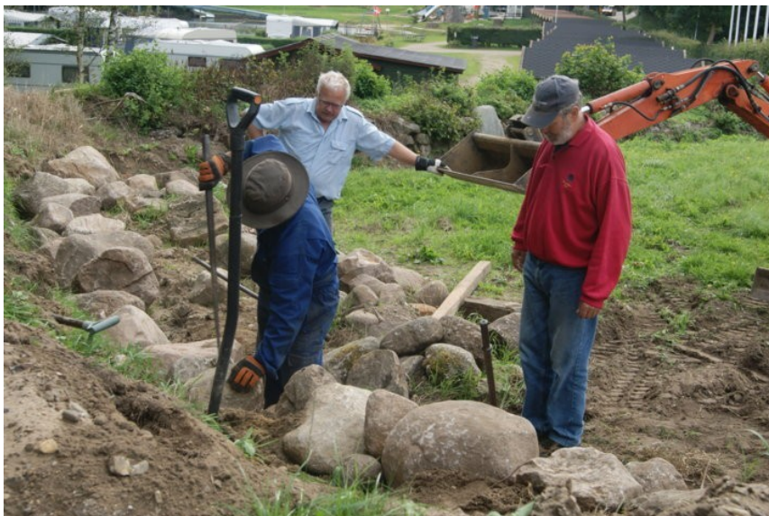
Forrest er det Julius Guttesen, der at ved at vrikke den tunge sten på plads med en jernstang. Til venstre for ham Søren Pallesen, og til højre er det Svend Aage Hansen.
