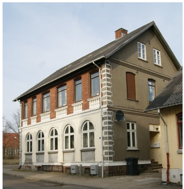
Billedet her er taget 26. september 2010. Facaden er ændret så meget at man ikke kan se, at her engang var købmandsforretning. (Foto N.M. Schaiffel-Nielsen)
